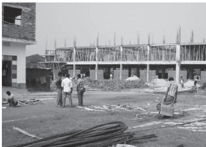
Bangladeshの工場の建設風景
